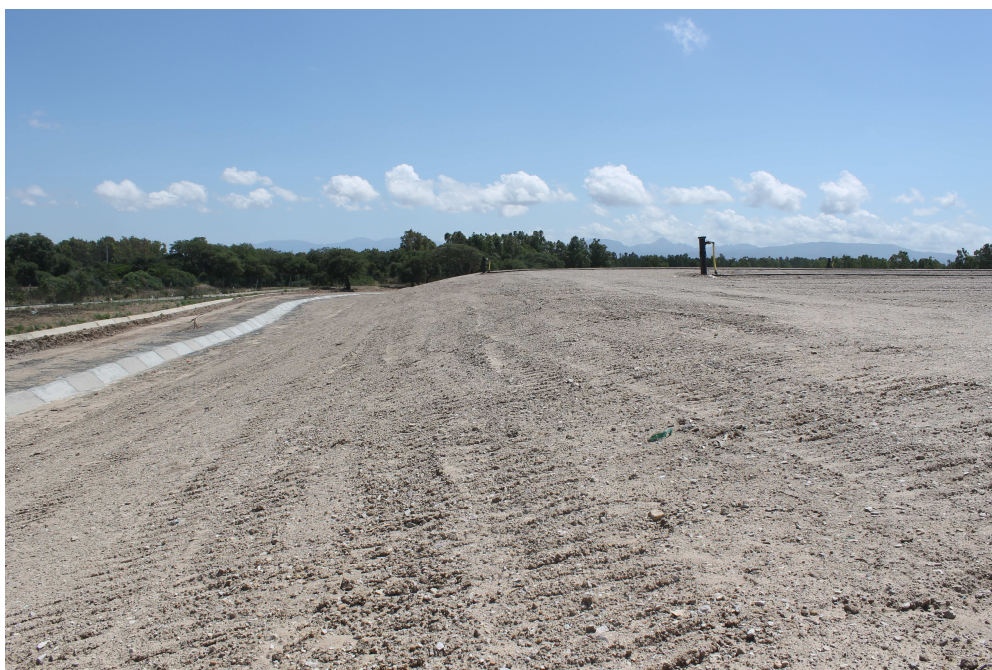
Figura 1 - Rimodellamento ricoprimento superficiale in terra Modulo 1
